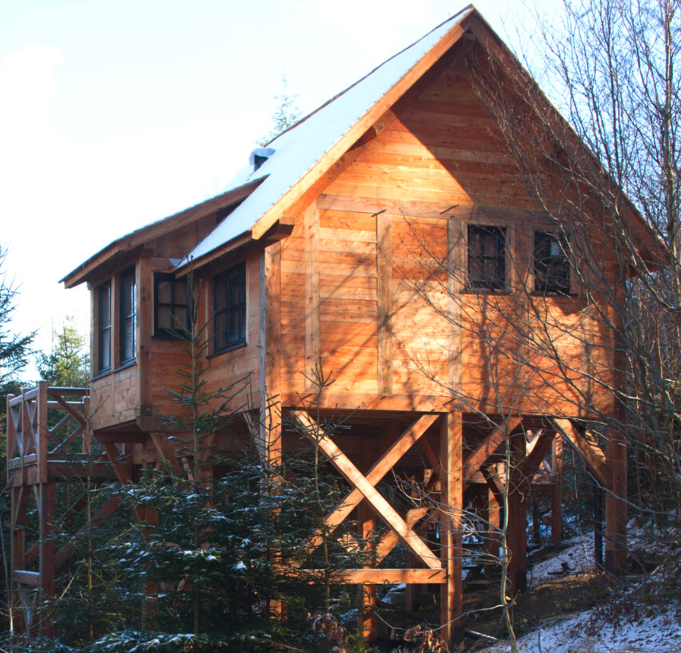
Tiny House sur pilotis (R14)
